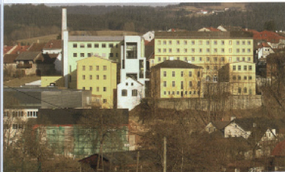
Die ehemalige Vonwiller Leineweberei mit dem neuen Textilen Zentrum
